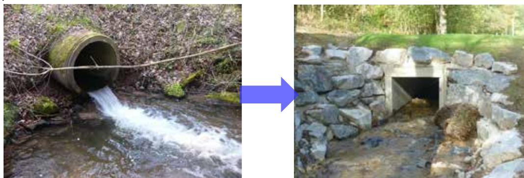
Chute d'eau en aval d'une buse mal calée
