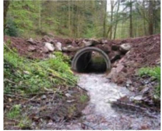
ou par une buse circulaire enterrée de 1/3, d'un diamètre suffisant pour l'absorption des crues
